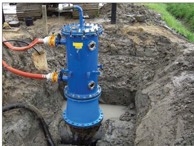
**Рис. 5. Запуск и извлечение прибора с помощью шлюза на фитингах**
