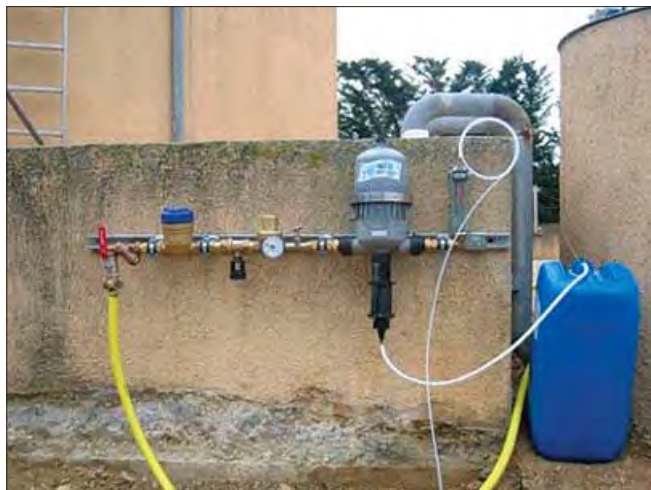
Рис. 2. Дозировочная насосная система с обязательным предварительным разбавлением препарата
