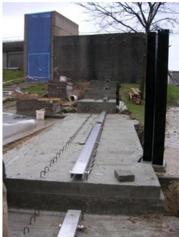
Заливка бетона и установка бортов
