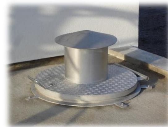
Крышка люка с вентиляционным каналом
