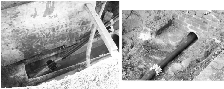
Рис. 4. Прокладка вакуумной канализации труба в трубе
