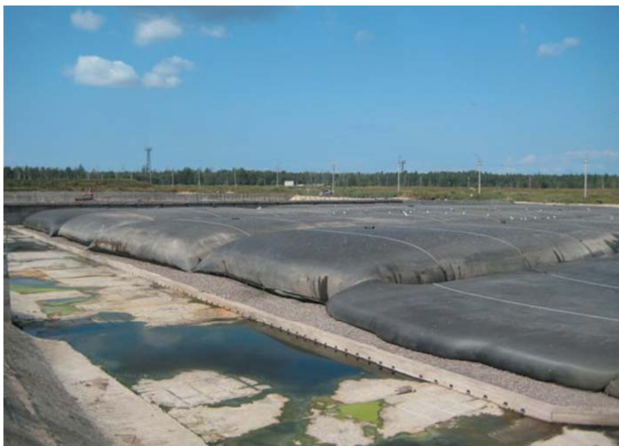
Рис. 2. Общий вид площадки с геотубами
