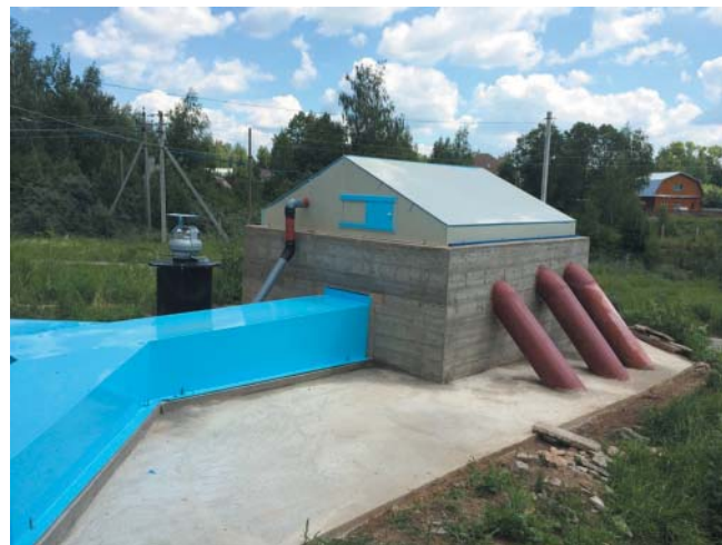
Рис. 3. Пластиковые перекрытия приемной камеры и установка адсорбционного фильтра серии ДС
