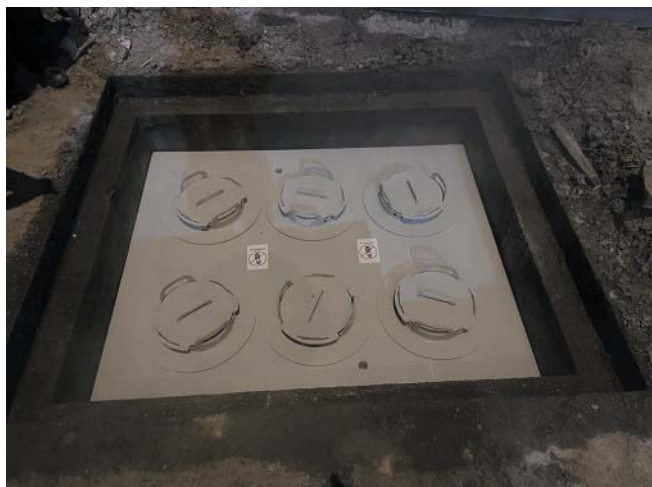
Рис. 4. Установка адсорбционного фильтра «Пьюр-Аэр» на шахте канализационного коллектора
