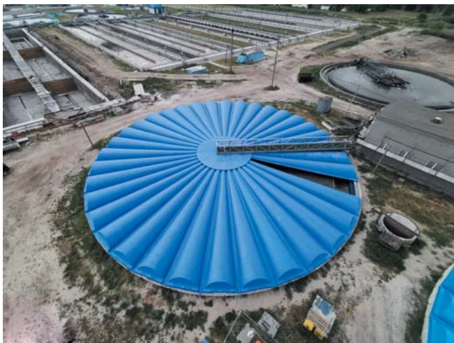
Рис. 2. Перекрытие первичного отстойника на очистных сооружениях
