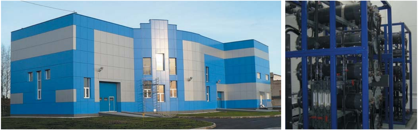
Рис. 1. Южная водопроводная станция ГУП «Водоканал Санкт Петербург»
