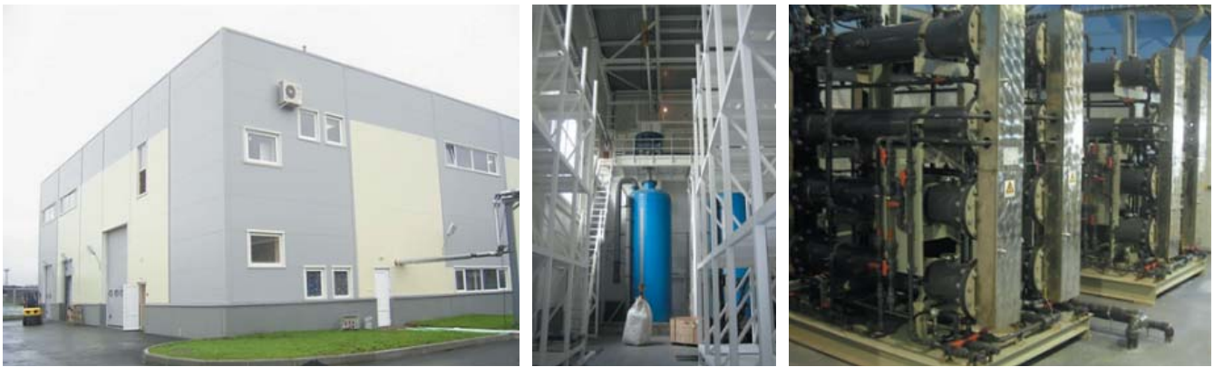
Рис. 2. Северная водопроводная станция ГУП «Водоканал Санкт Петербург»
