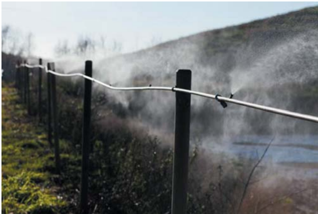
Рис. 3. Специальная рампа для распыления реагента с целью устранения возможного неприятного запаха
