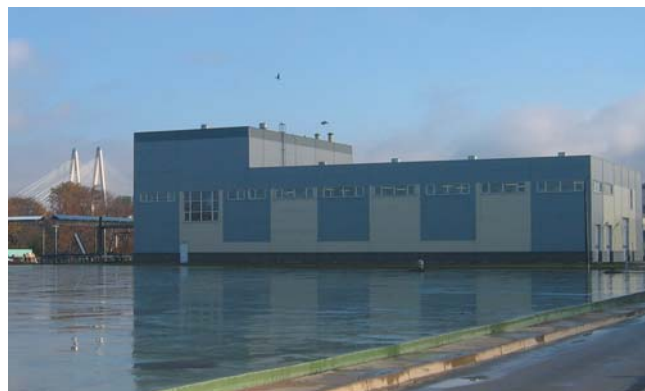
Рис. 2. Цех по производству низкоконцентрированного гипохлорита натрия на Южной водопроводной станции
